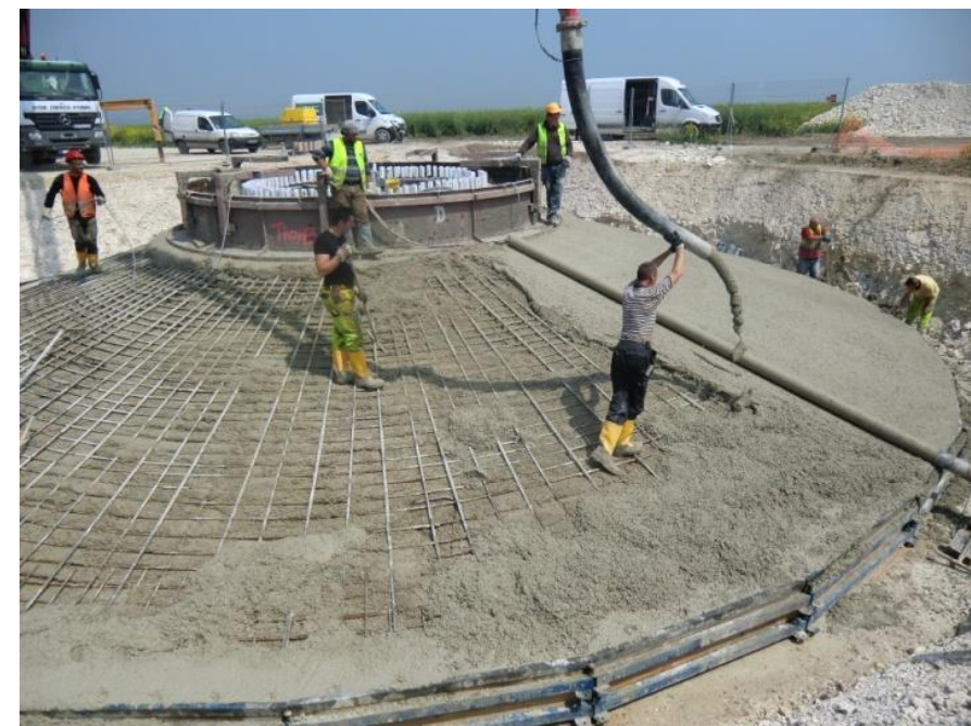
Photo 4 : Coulage du béton
