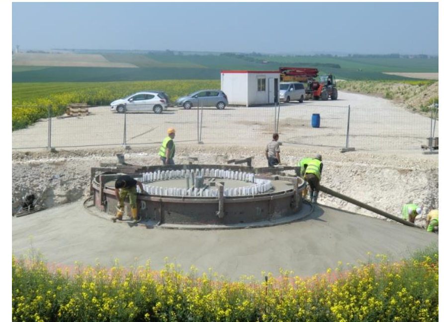
Photo 5 : Béton terminé
