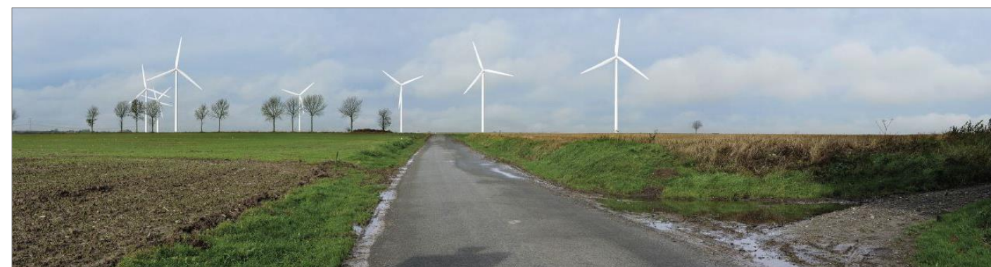
Figure 14 : Sortie nord-ouest de Boffles – RD 116
